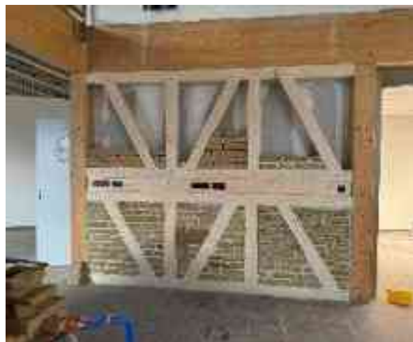
Photo de chantier prise le 26/11/2025
