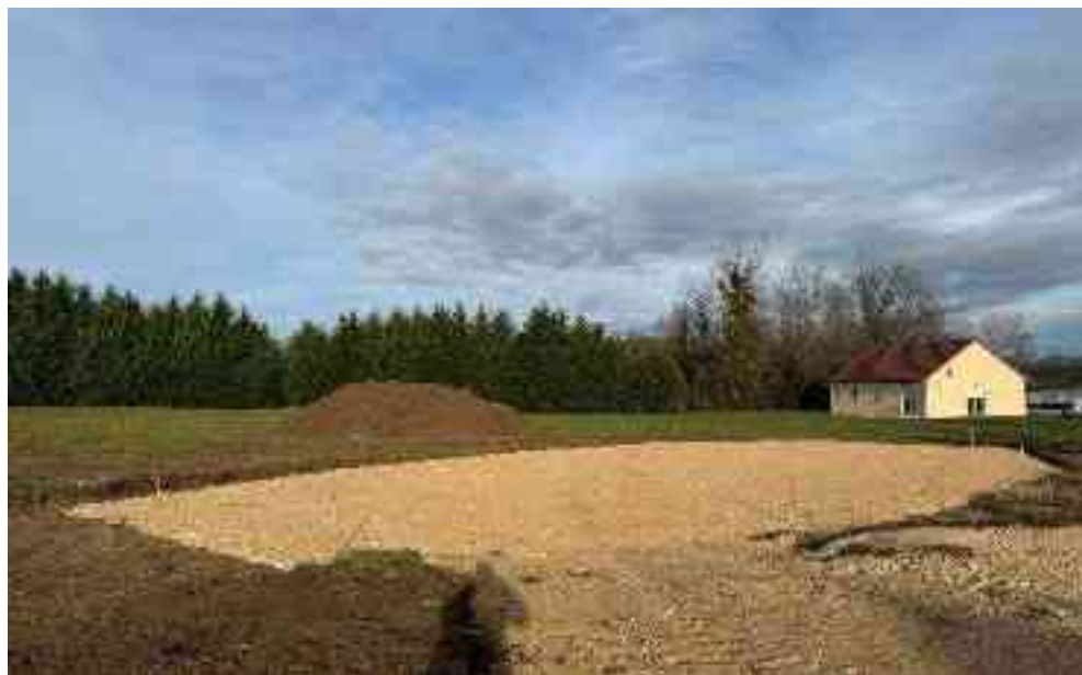
Photo de chantier prise le 15/01/2025
