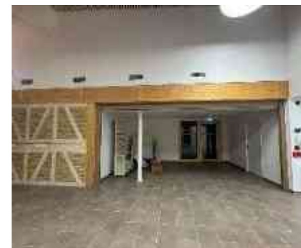
Photo de chantier prise le 16/01/2026
