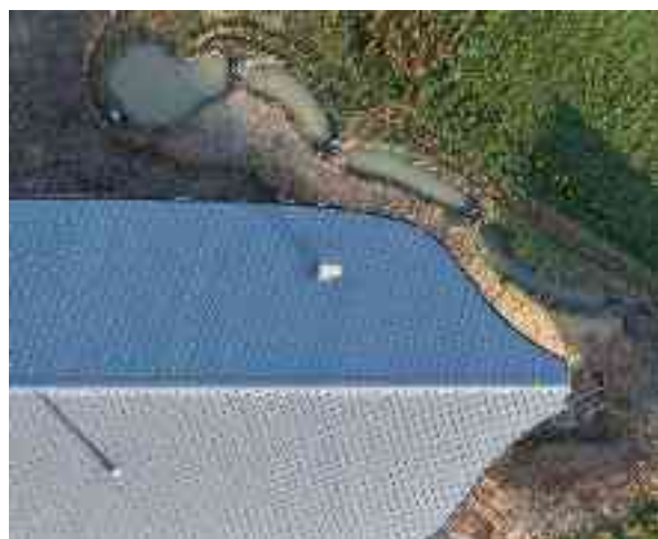
Photo de chantier prise le 12/12/2025
