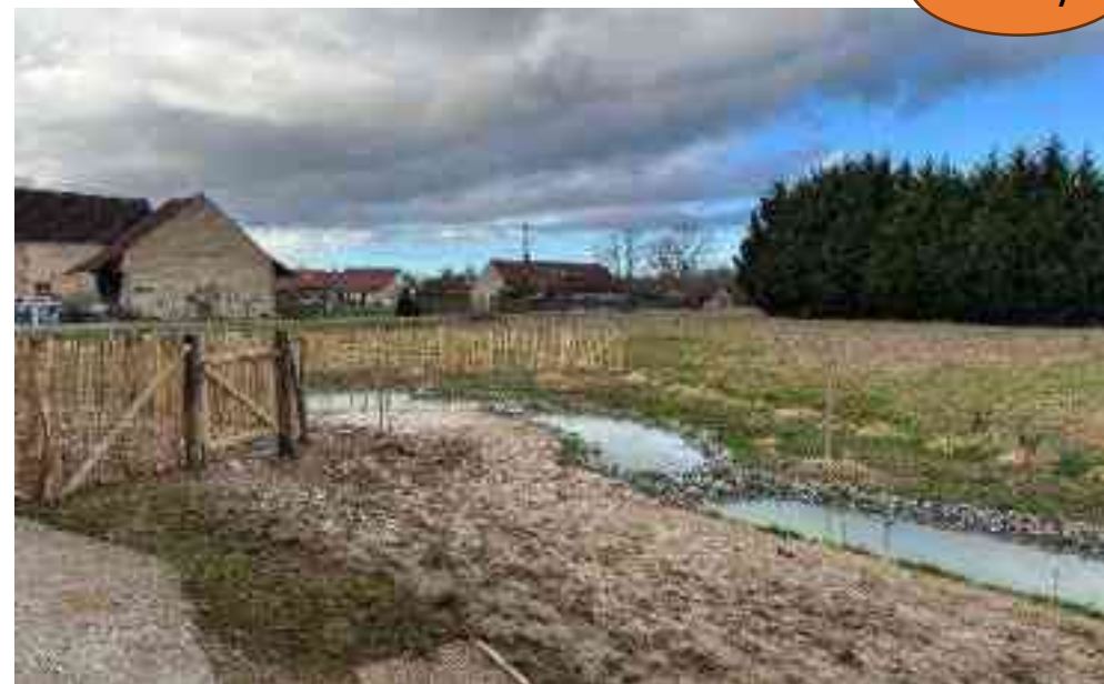
Photo de chantier prise le 18/02/2026
