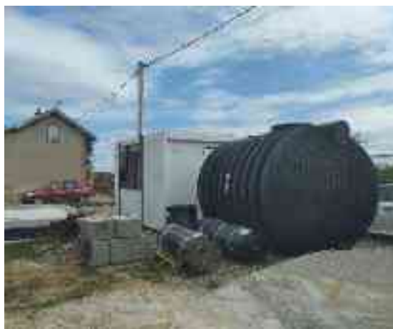
Photo de chantier prise le 16/07/2025
