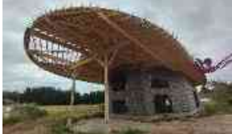
Photo de chantier prise le 28/05/2025
