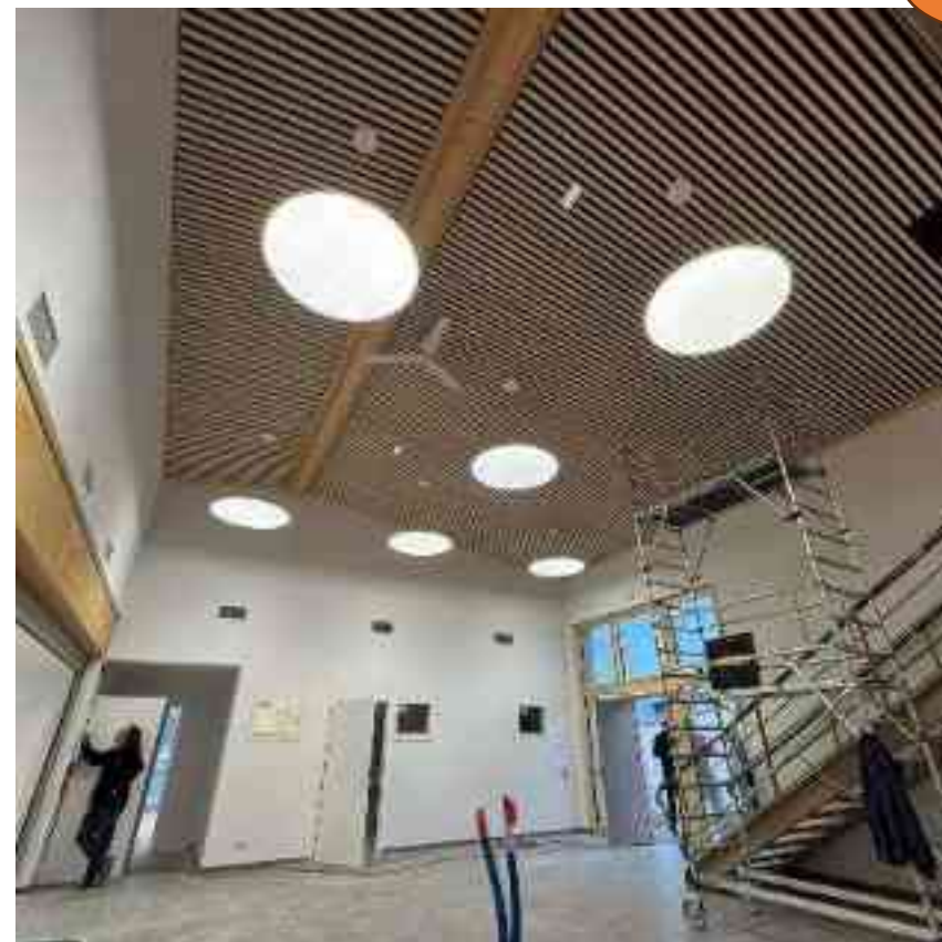
Photo de chantier prise le 12/12/2025
