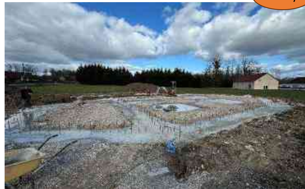
Photo de chantier prise le 26/02/2025
