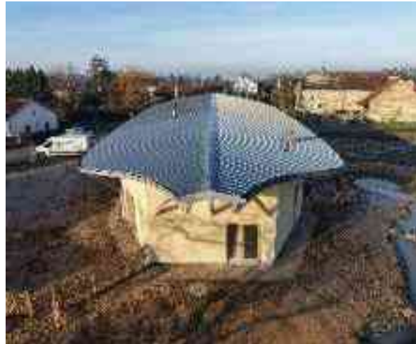
Photo de chantier prise le 12/12/2025
