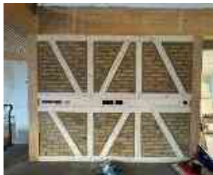
Photo de chantier prise le 03/12/2025
