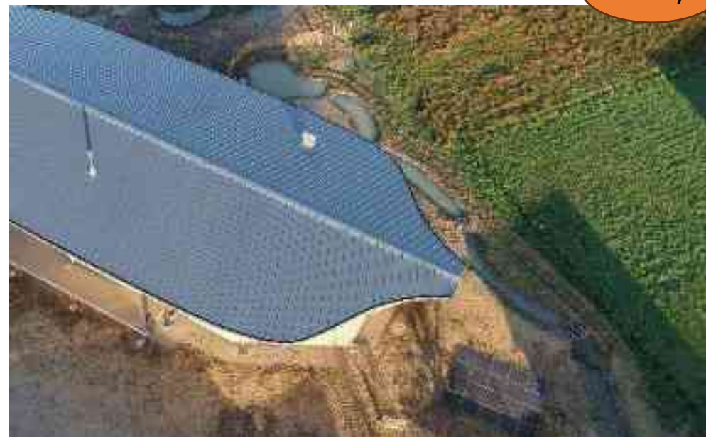
Photo de chantier prise le 12/12/2025
