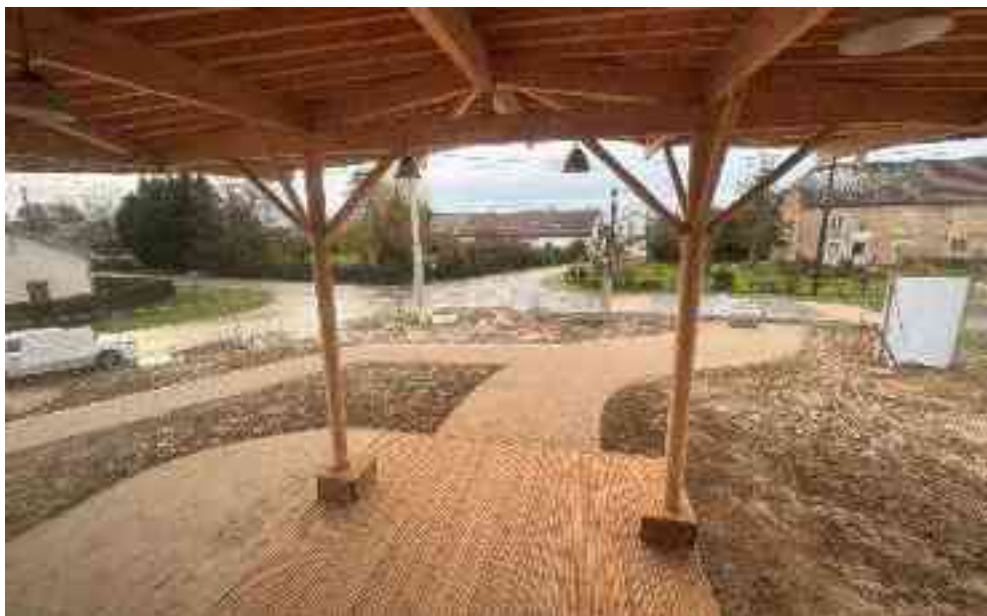
Photo de chantier prise le 03/12/2025
