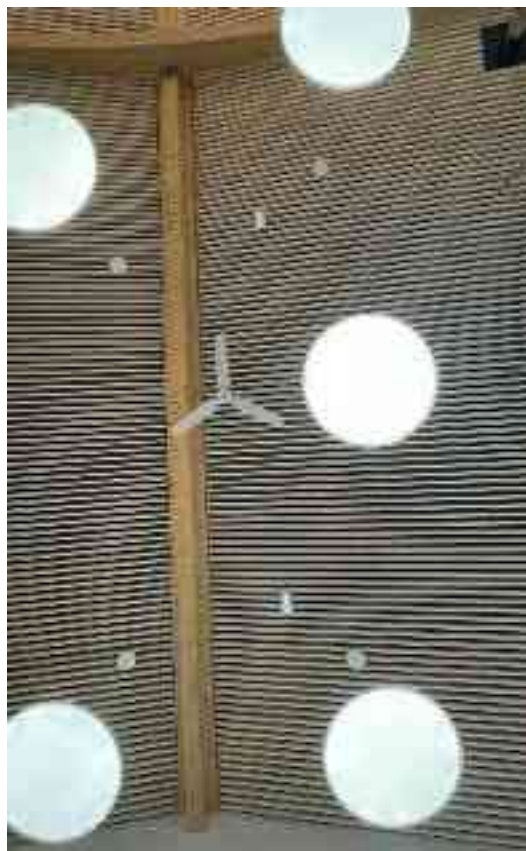
Photo de chantier prise le 12/12/2025
