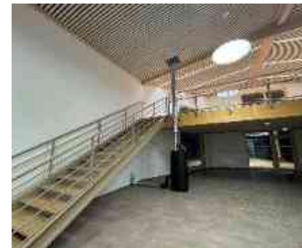
Photo de chantier prise le 16/01/2026
