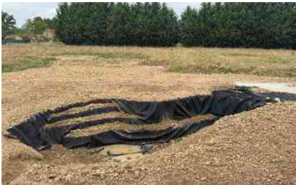
Photo de chantier prise le 27/08/2025
