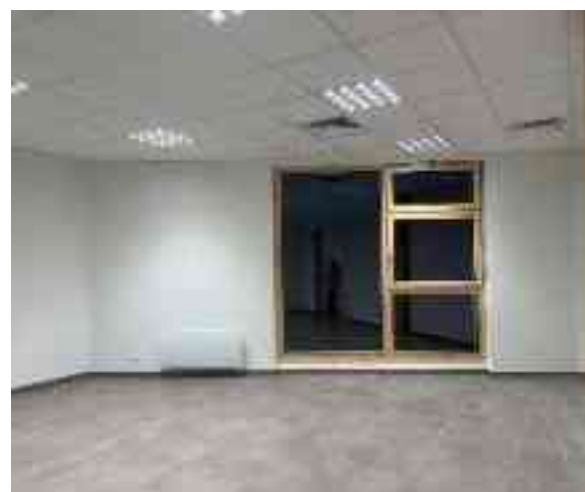
Photo de chantier prise le 16/01/2026
