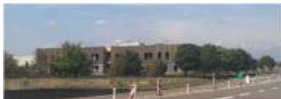
Crédit agricole au Sud-Ouest avec bardage bois
